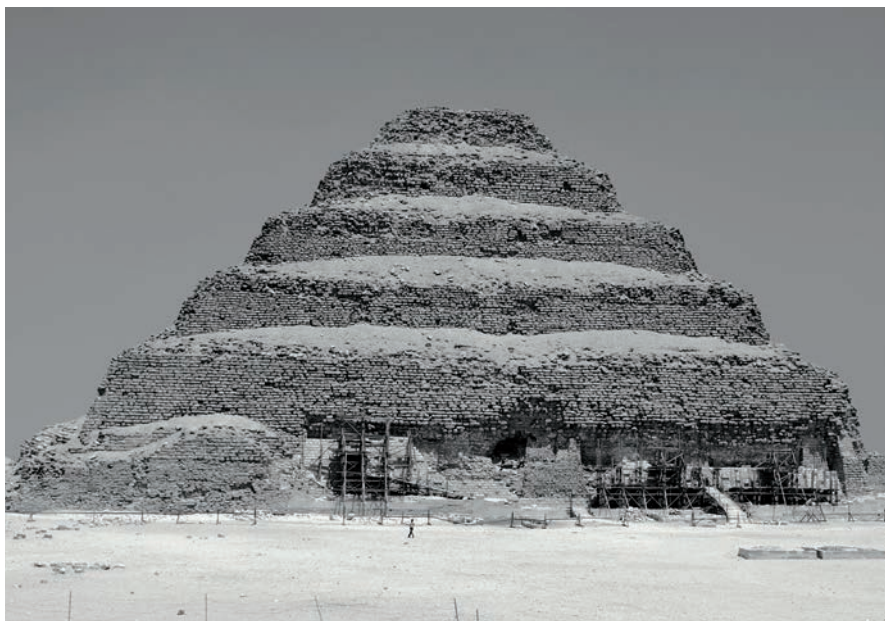
TRAPPSTEGSPYRAMIDEN I SAQQARA, BYGGD FÖR KUNG DJOSER UNDER 3:E DYNASTIN (CA 2668–2649 F. KR), VAR EGYPTIERNAS FÖRSTA FÖRSÖK ATT BYGGA STORSKALIGT I STEN. MAN LITADE ÄNNU INTE HELT PÅ STENENS EGENSKAPER OCH HÖGG DEN DÄRFÖR I BLOCK AV SAMMA STORLEK SOM LERTEGEL.
