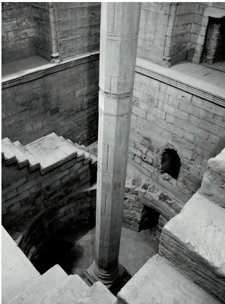
NILOMETERN HAR SENARE FÖRSETTS MED ETT SPETSIGT TAK, MEN SER I ÖVRIGT EXAKT UT SOM I WALLINS BESKRIVNING. DEN ANVÄNDS DOCK INTE LÄNGRE OCH ÖPPNINGARNA, GENOM VILKA NILVATTNET TIDIGARE STRÖMMADE IN, HAR Fyllts IGEN.
