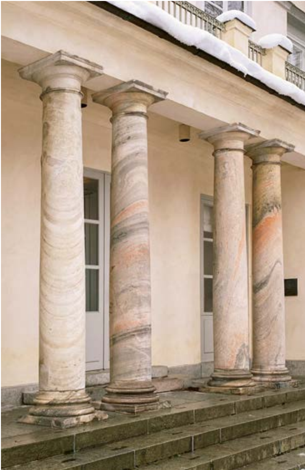
Haga slott, entrén. Kolonnerna är huggna av Vestlaxmarmor och är troligen fyra av de 14 kolonner Gustav IV Adolf köpte från Karlskrona. Foto: Eva Johansson.
