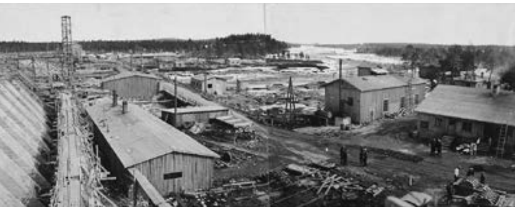
Jäniskoski Power Plant
